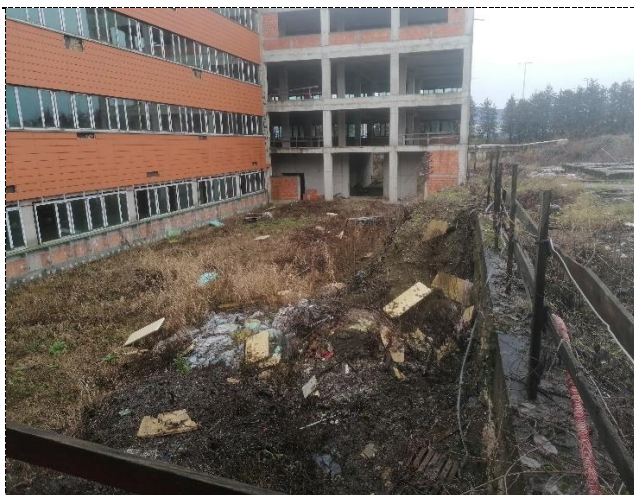
Pogled na središnji dio parcele u smjeru jug-sjever - - građevna jama
