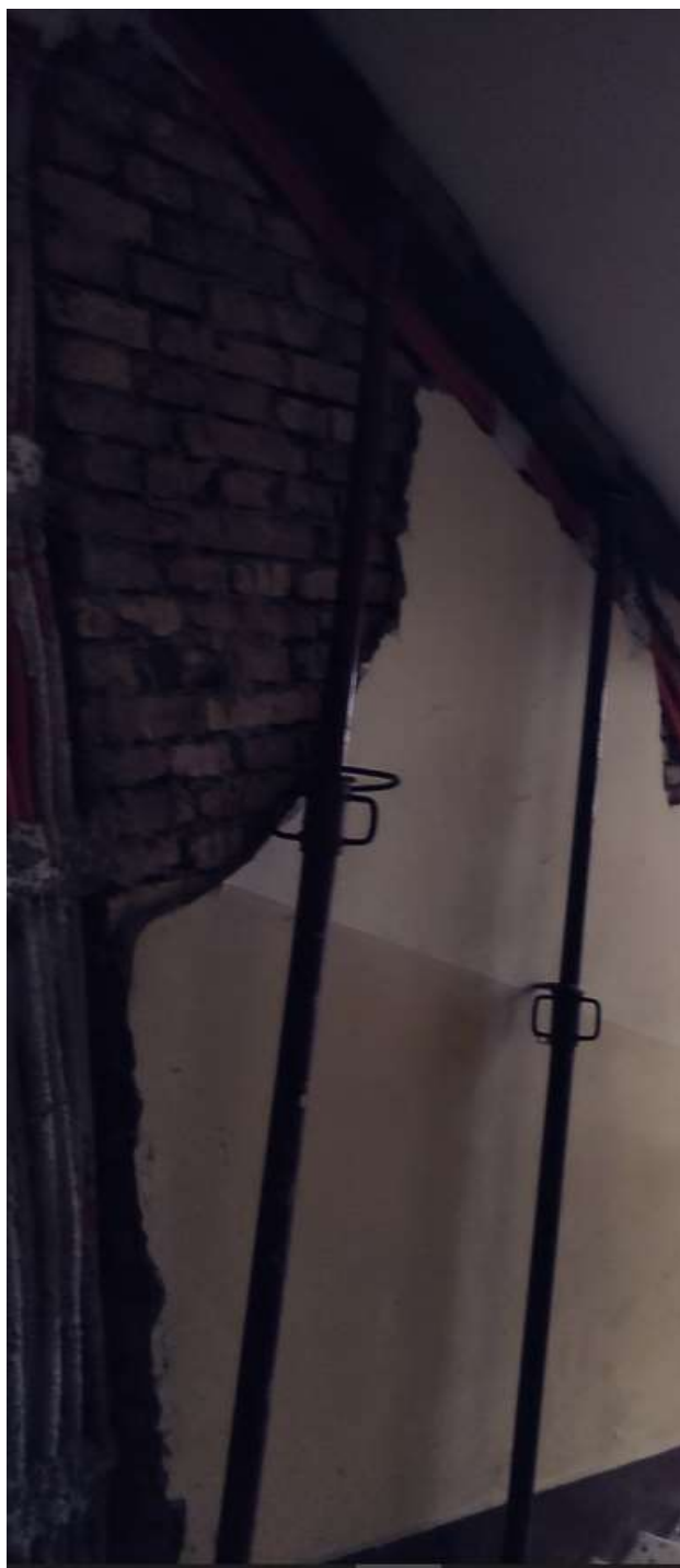
dijagonalna pukotina na zidu stubišta
