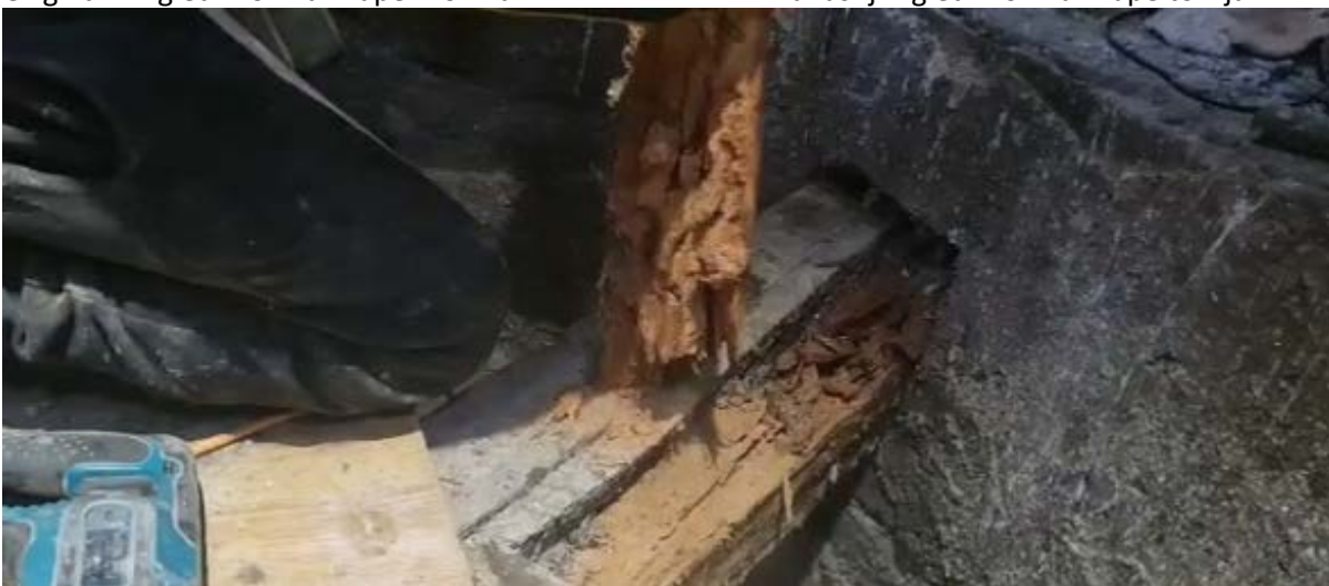
Istrunule grede koje su zazidane; prije dogradnje ležale na oktagonu
