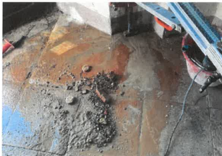
Slika 2 Materijal izvađen bušenjem zidanih elemenata
