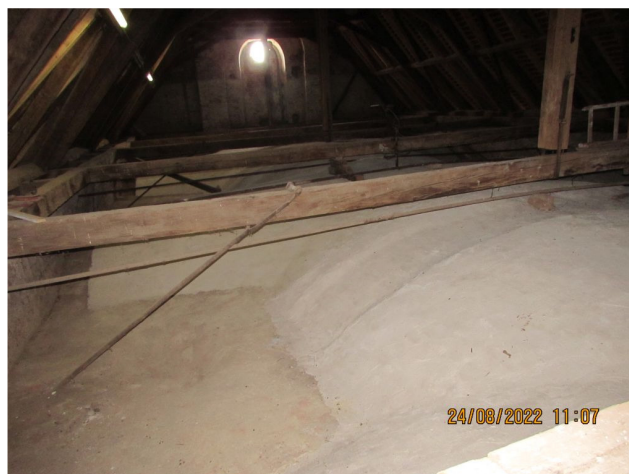
Saniran svod nad crkvom
