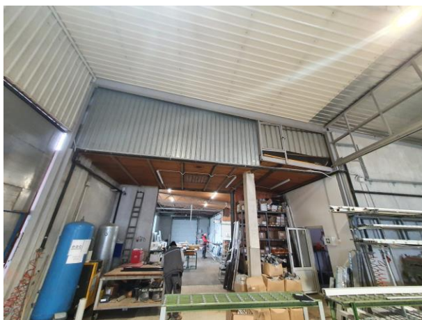
Unutarašnjost hale u limenim sendvič panelima i lamperiji
