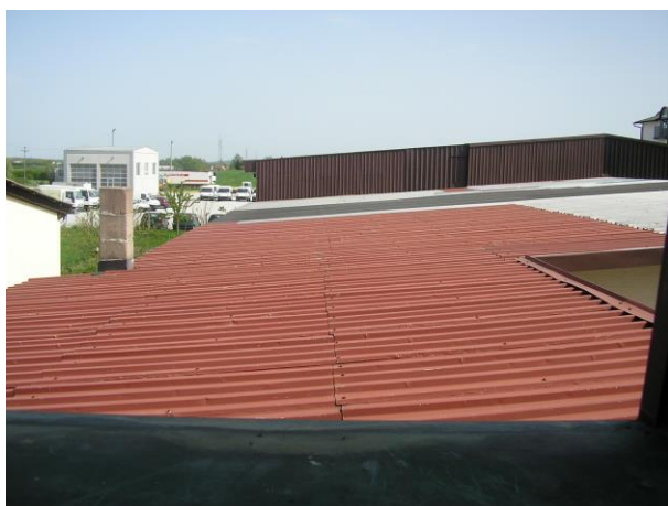
Krovne plohe i zabatni zid na spoju krovnih ploha (lim i limeni sendvič paneli)
