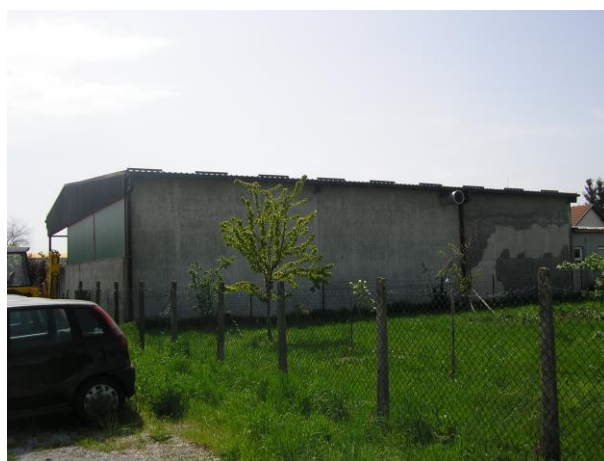
Jl pročelje (s kopilit staklom) i SI pročelje (zid od blok opeke bez izolacije)
