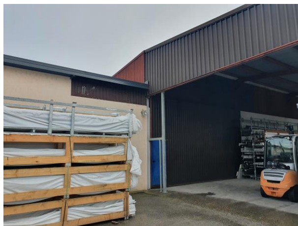
Dio zida JZ pročelja s ispunom od limenih panela (zamjena - st. stavka 11)
