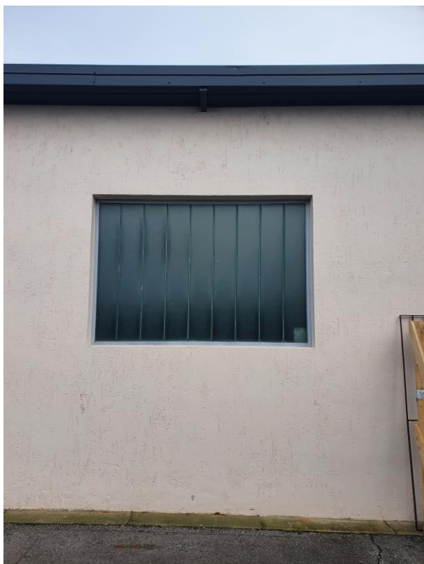
Detalj prozora na JZ pročelju s kopilit staklom - st. stavka 2
