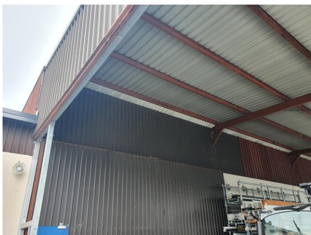
Dio vanjskog zida JZ pročelja (pod nadstrešnicom s ispunom od limenih panela
