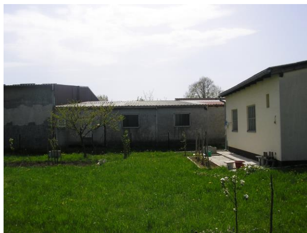
Jl pročelje (s kopilit staklom) i SI pročelje (zid od blok opeke bez izolacije)
