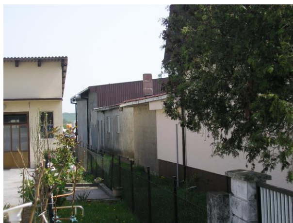
SI pročelje s pogledom na zabatni zid na spoju nižeg i više krovne plohe (ispuna limeni sendvič panel)
