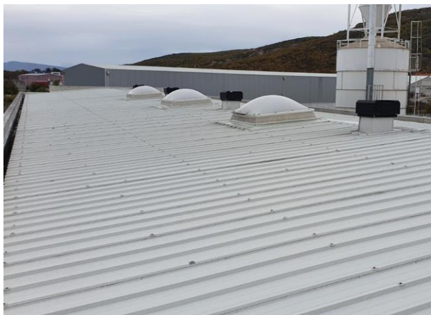
Slika 1. Proizvodni pogon Špandau - krov
