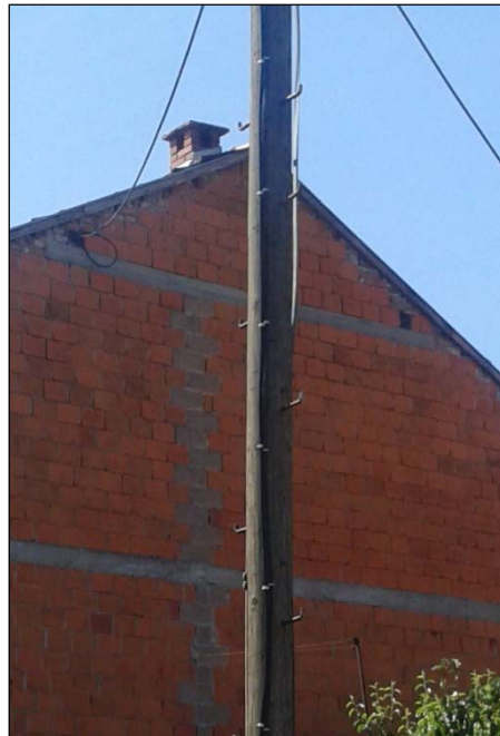
NASTUPAK - Nogari za penjanje uz stup
