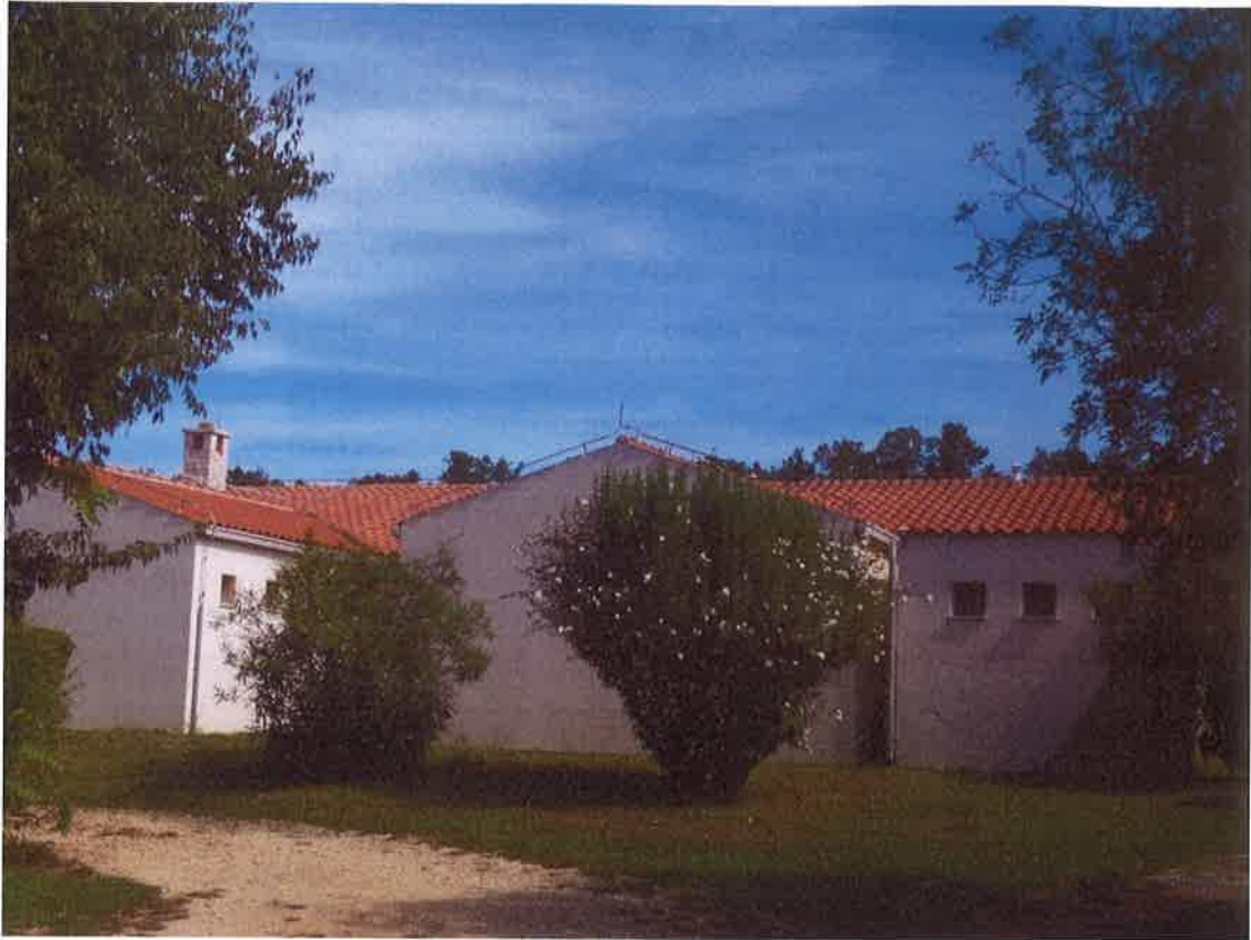
Slika 26 – Prikaz postojećeg stanja sanitarnog čvora 1 (3)
