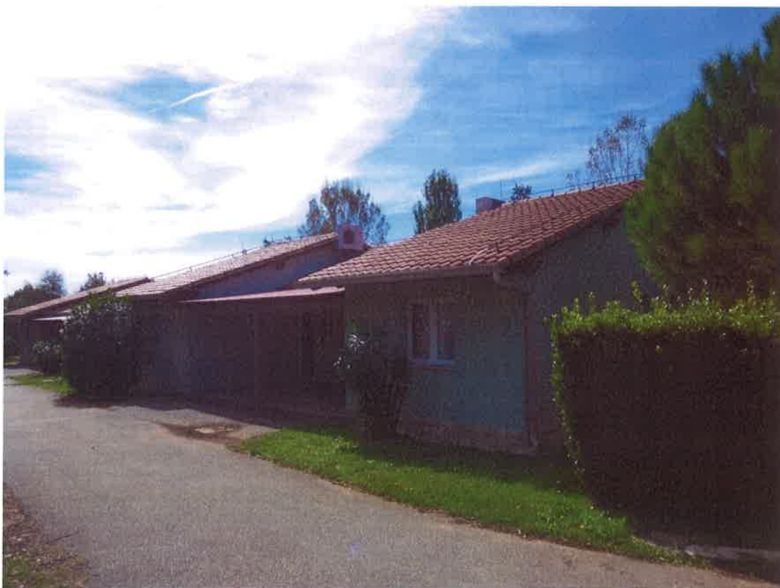
Slika 19 – Prikaz postojećeg stanja tipskog apartmana M90 (3)
