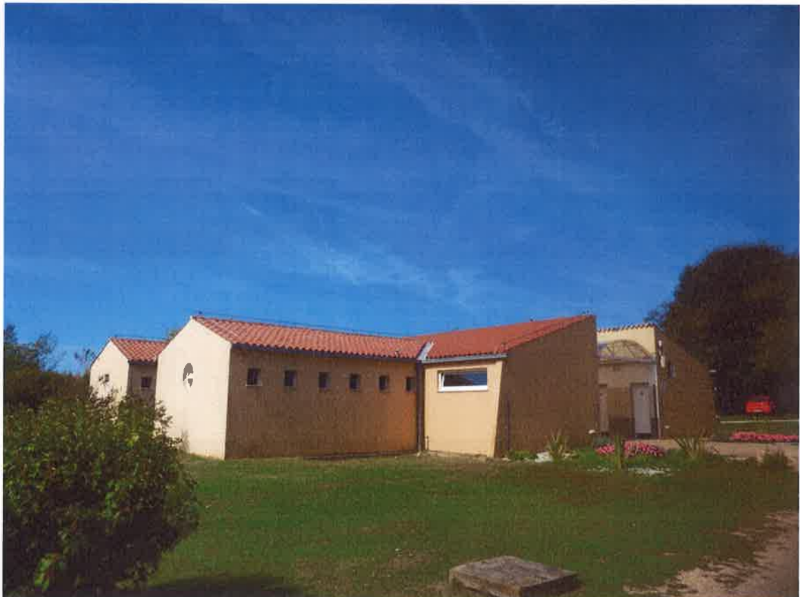
Slika 35 – Prikaz postojećeg stanja sanitarnog čvora 3 (4)
