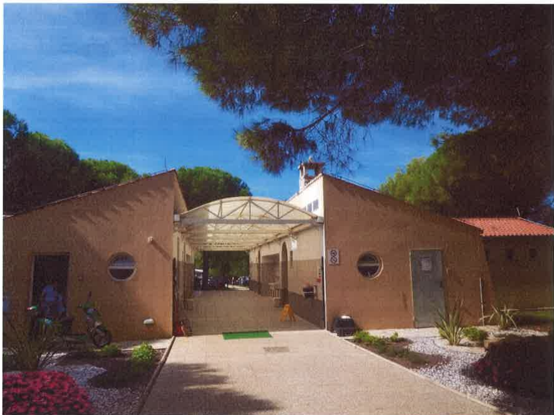
Slika 37 – Prikaz postojećeg stanja sanitarnog čvora 4 (1)
