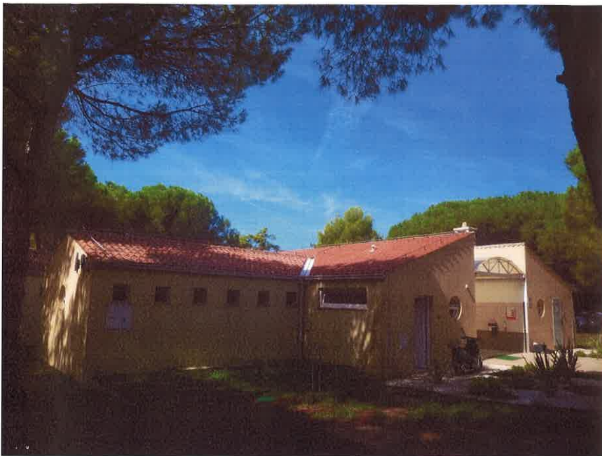
Slika 38 – Prikaz postojećeg stanja sanitarnog čvora 4 (2)
