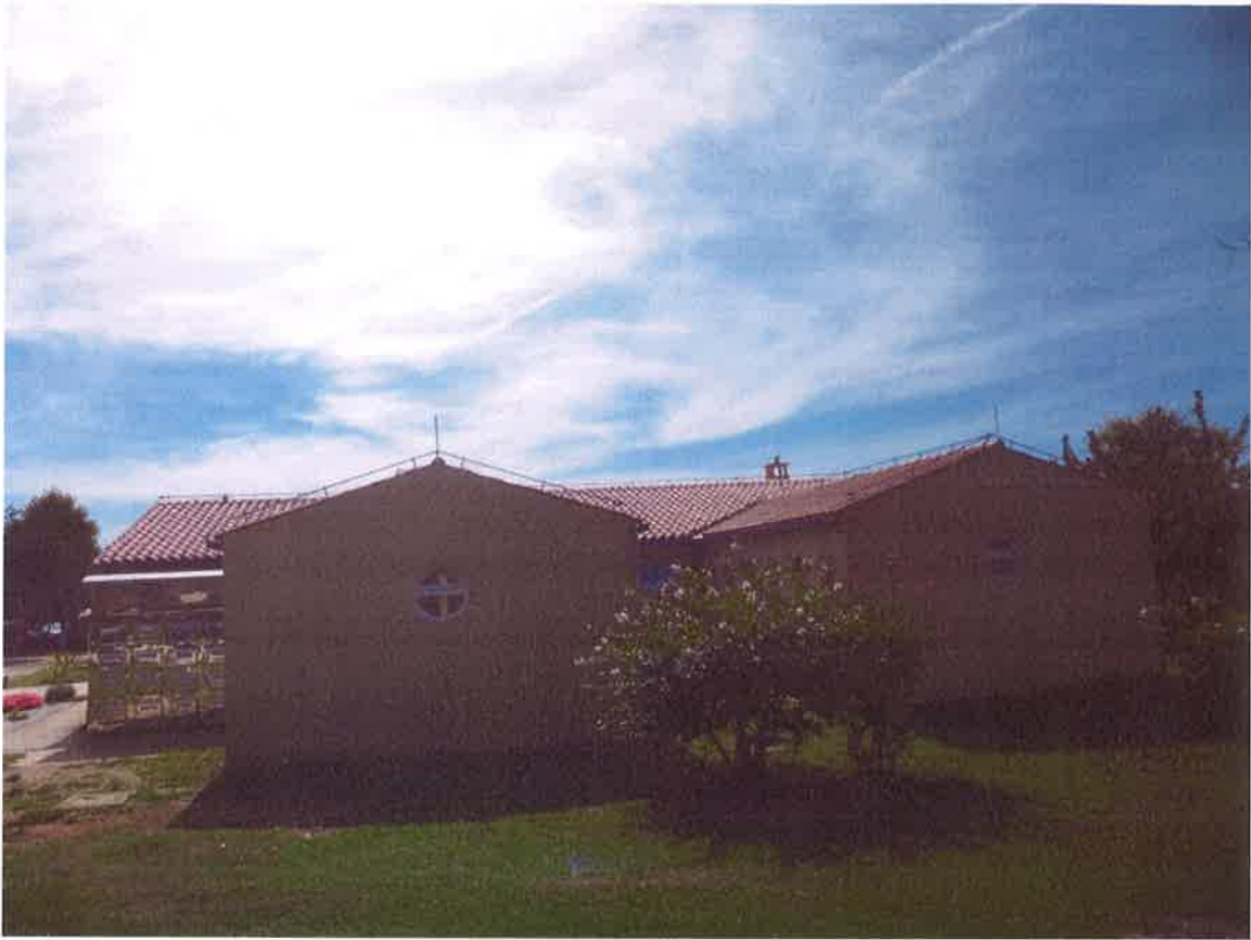
Slika 34 – Prikaz postojećeg stanja sanitarnog čvora 3 (3)
