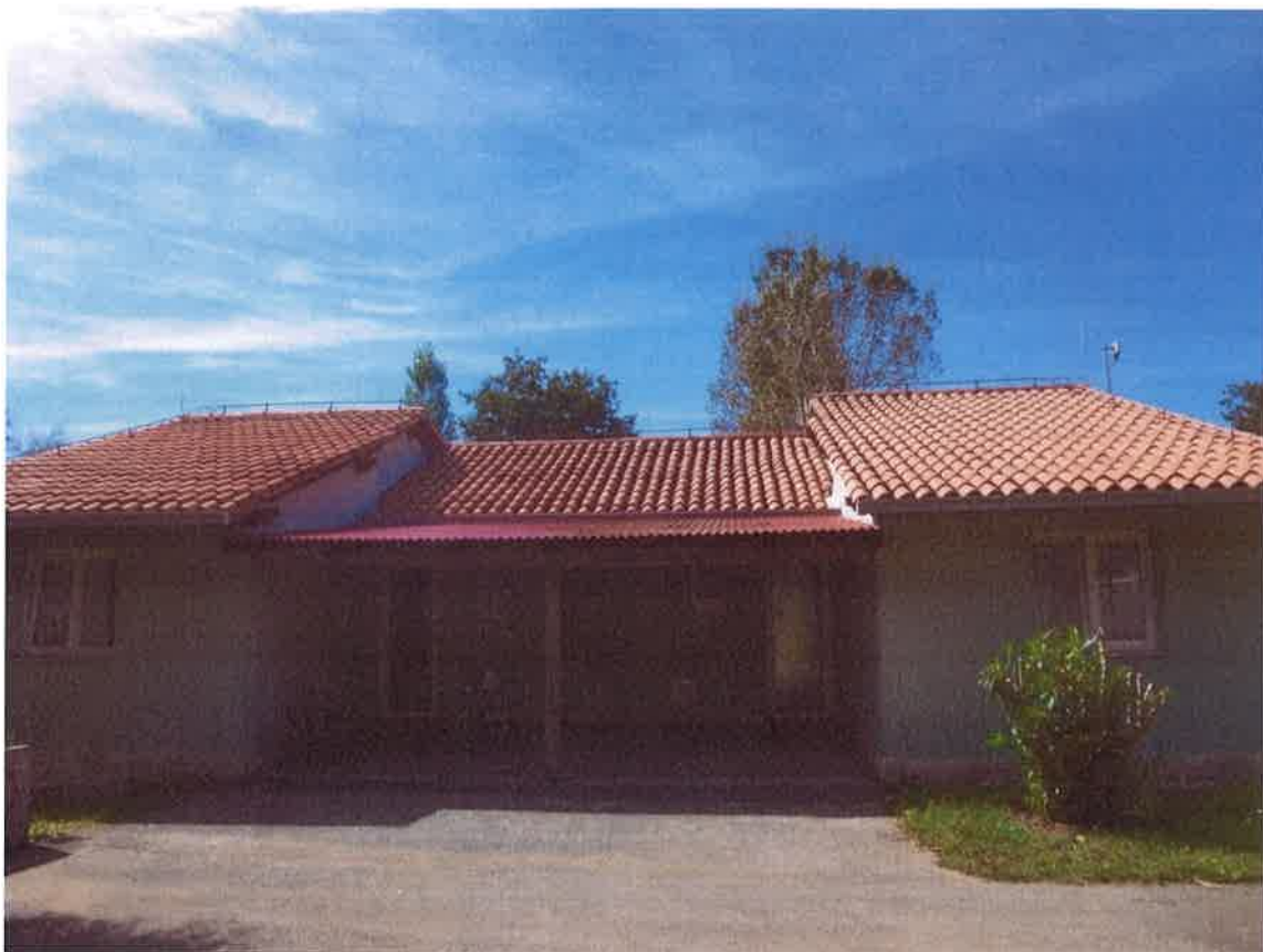
Slika 20 – Prikaz postojećeg stanja tipskog apartmana M90 (4)
