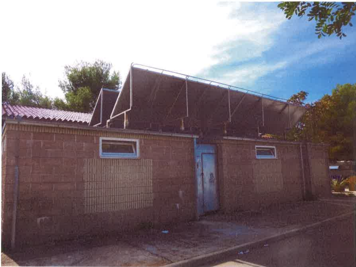
Slika 44 – Prikaz postojećeg stanja sanitarnog čvora 5 (3)
