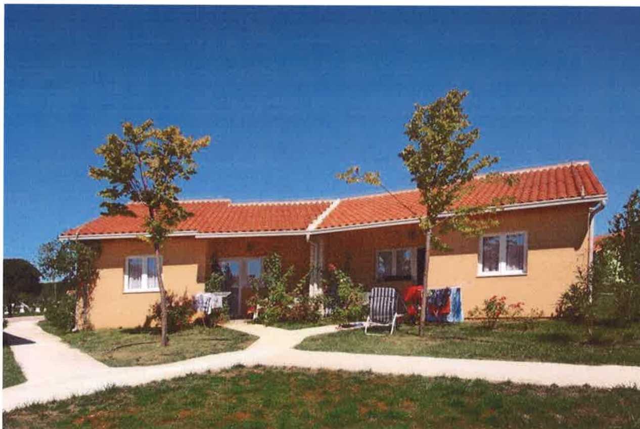
Slika 23 – Prikaz postojećeg stanja tipskog apartmana M95 (2)
