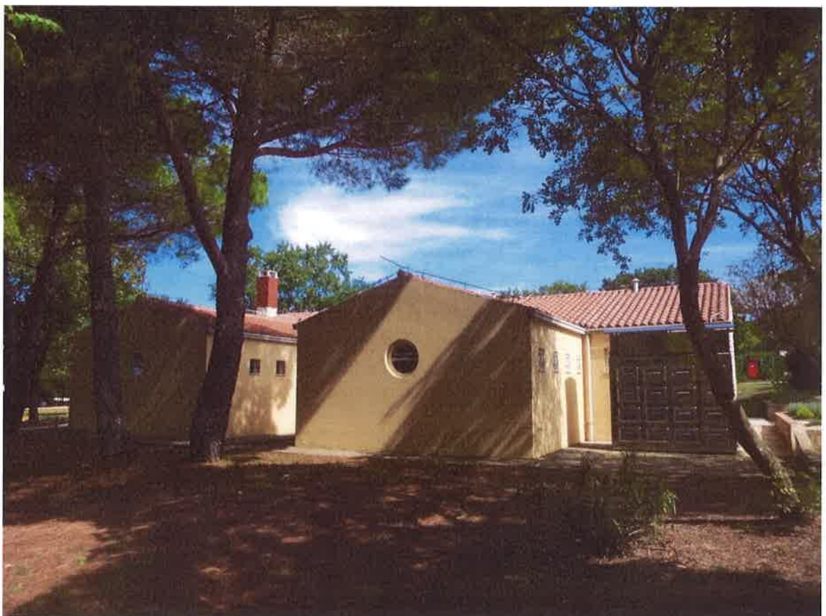
Slika 31 – Prikaz postojećeg stanja sanitarnog čvora 2 (5)
