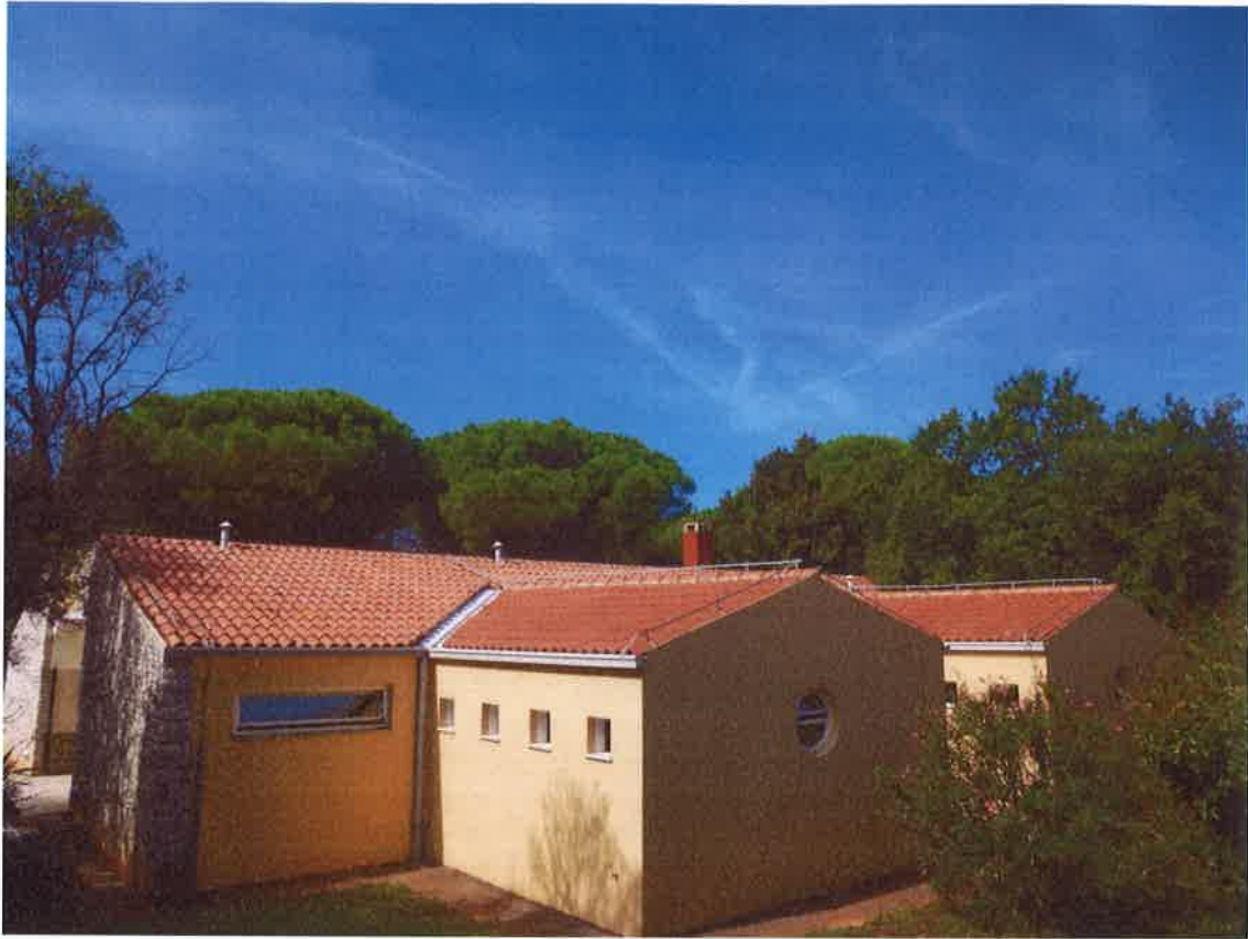
Slika 28 – Prikaz postojećeg stanja sanitarnog čvora 2 (2)
