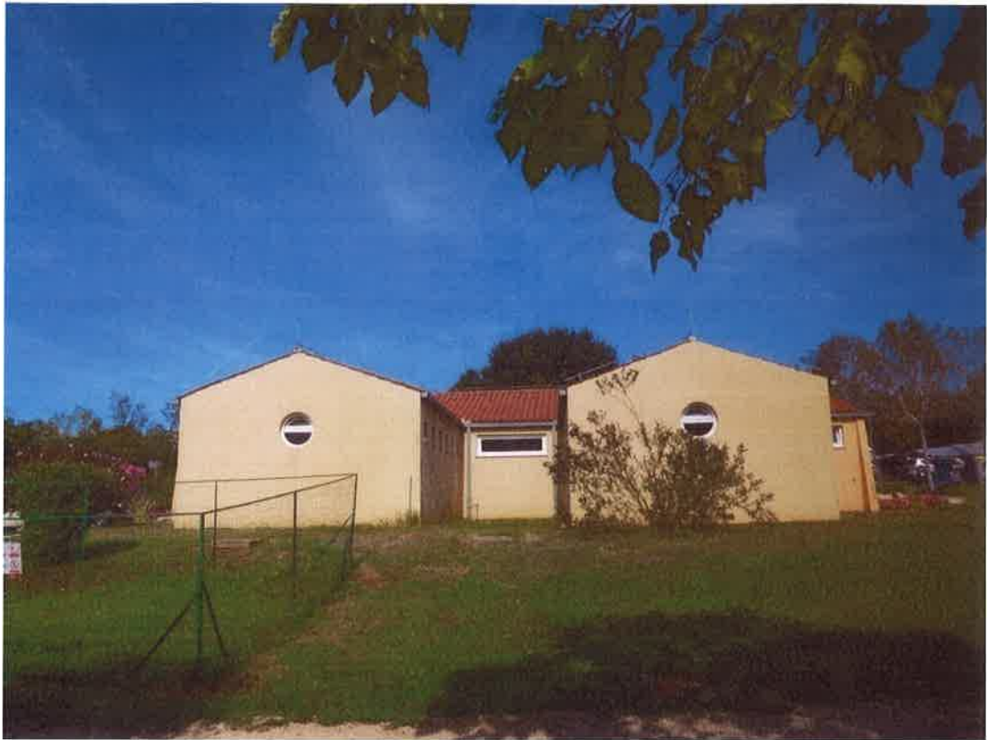
Slika 36 – Prikaz postojećeg stanja sanitarnog čvora 3 (5)
