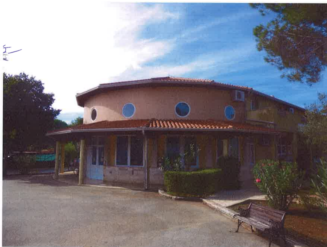
Slika 5 – prikaz postojećeg stanja upravne zgrade (2)
