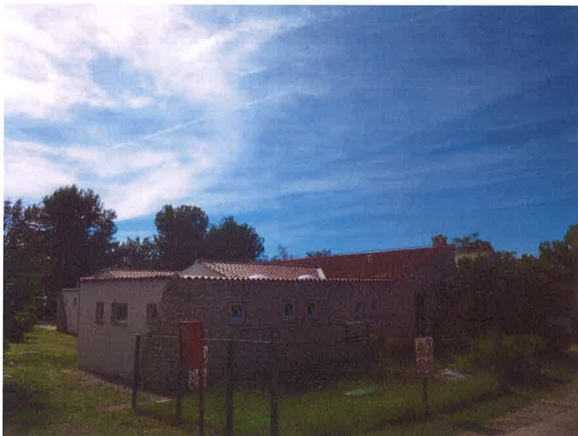
Slika 25 – Prikaz postojećeg stanja sanitarnog čvora 1 (2)
