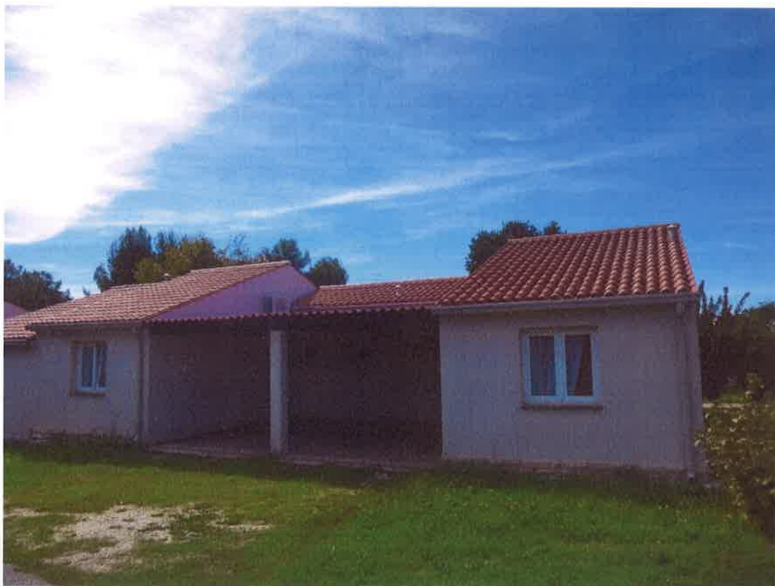
Slika 13 – Prikaz postojećeg stanja tipskog apartmana M60 (3)
