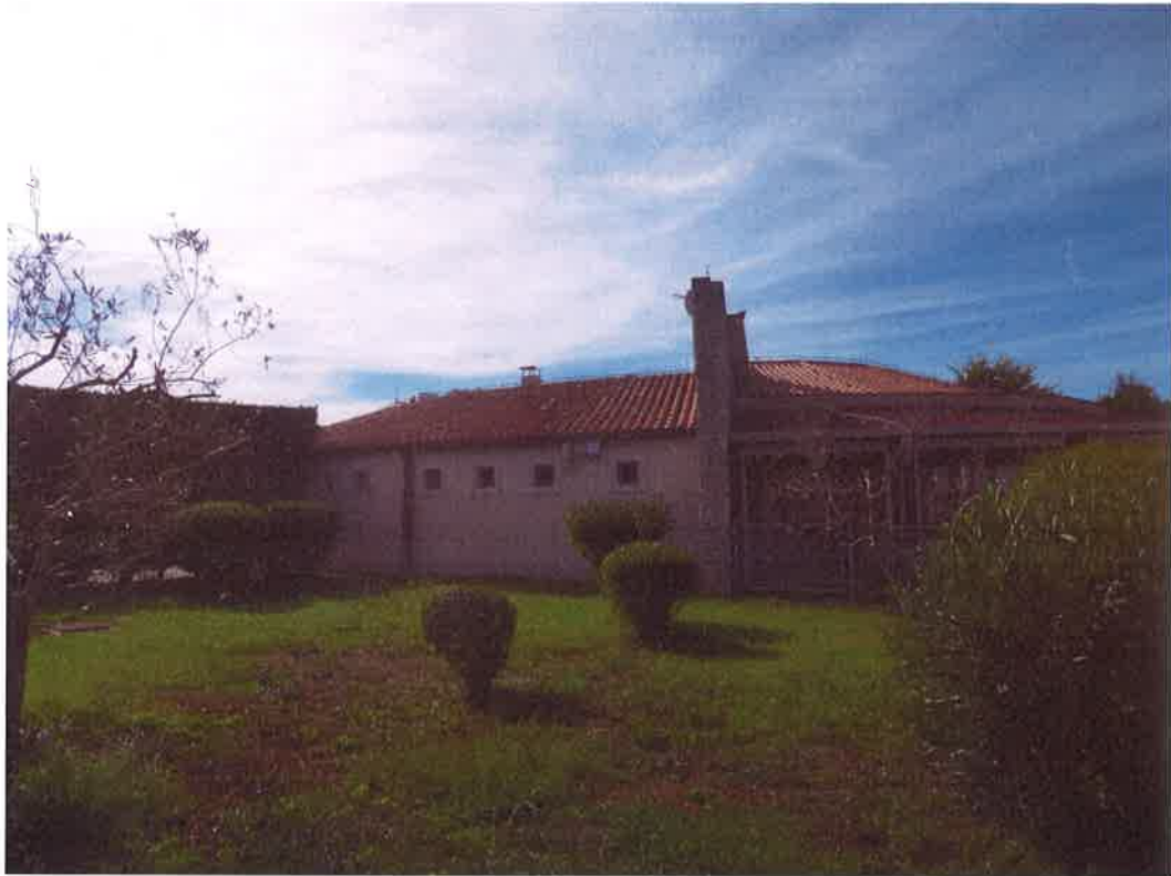
Slika 10 – Prikaz postojećeg stanja restorana (3)
