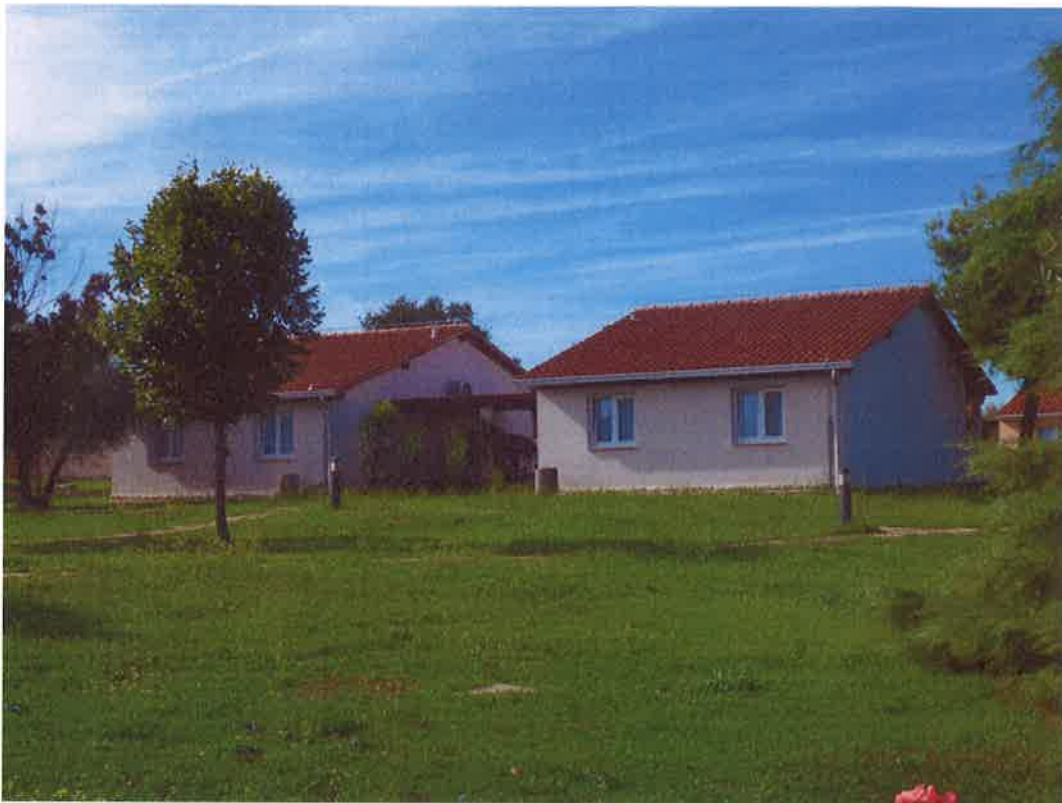
Slika 18 – Prikaz postojećeg stanja tipskog apartmana M90 (2)
