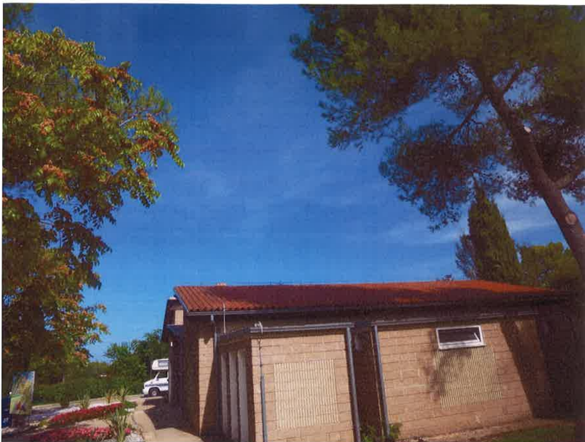
Slika 42 – Prikaz postojećeg stanja sanitarnog čvora 5 (1)
