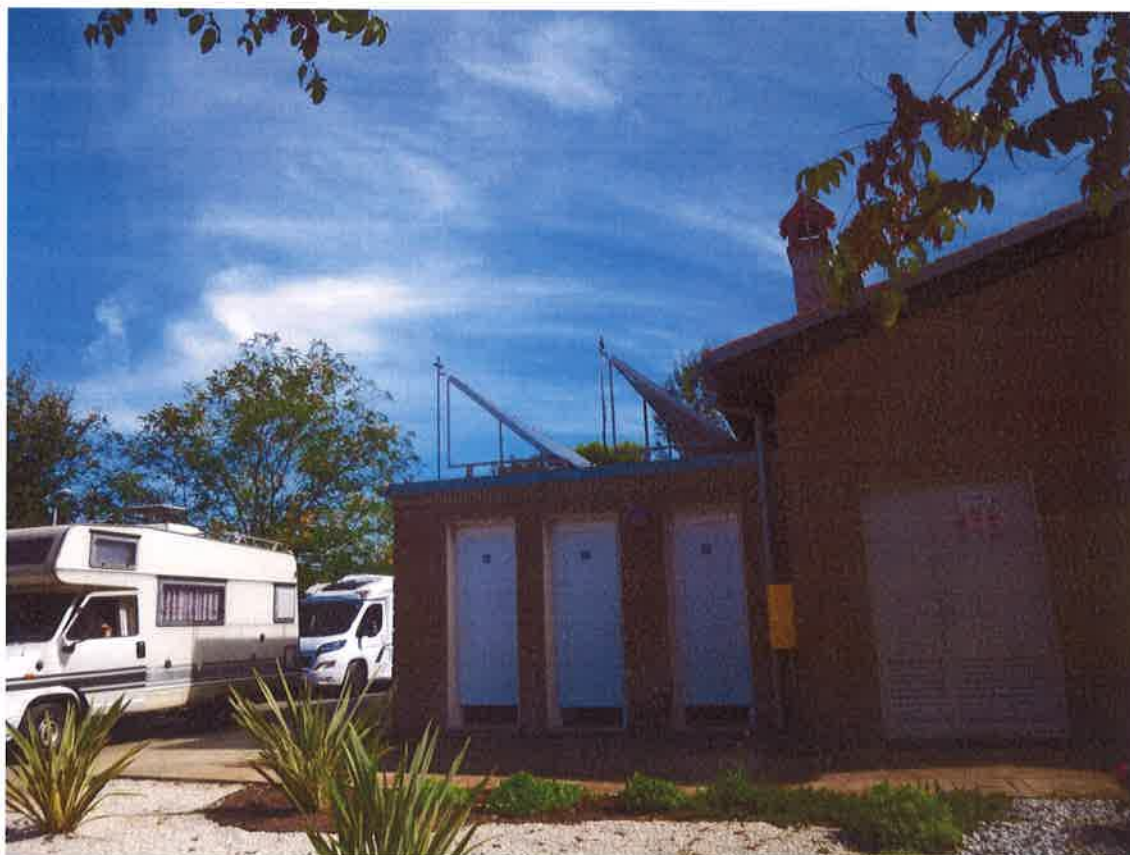
Slika 43 – Prikaz postojećeg stanja sanitarnog čvora 5 (2)
