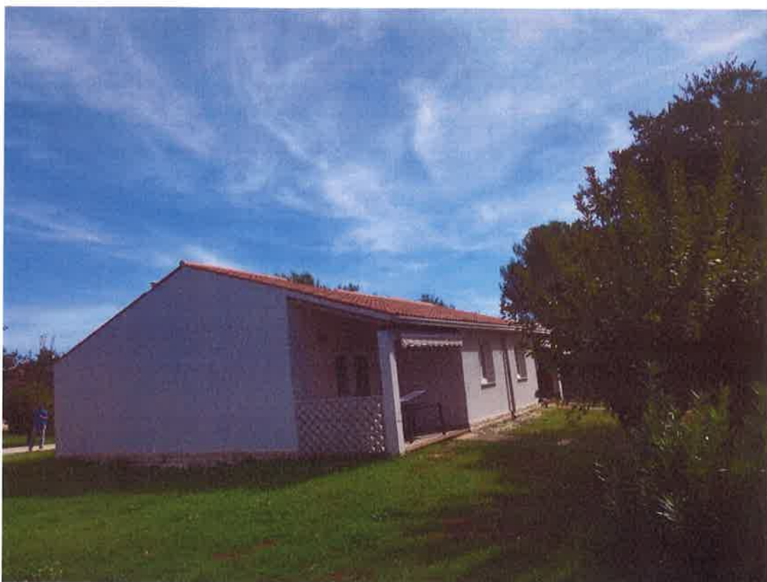
Slika 12 – Prikaz postojećeg stanja tipskog apartmana M60 (2)
