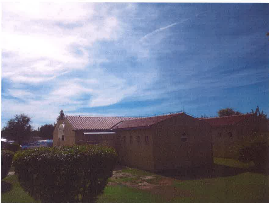
Slika 33 – Prikaz postojećeg stanja sanitarnog čvora 3 (2)
