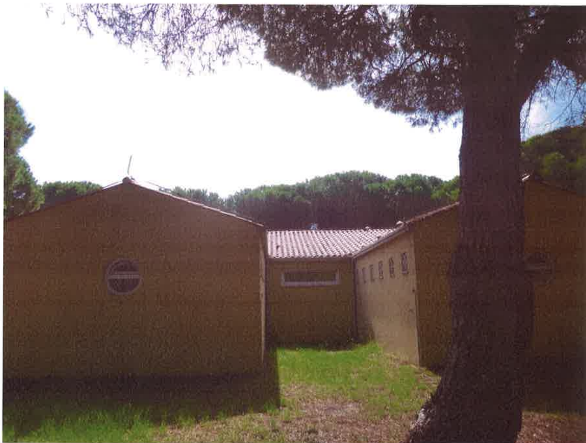
Slika 40 – Prikaz postojećeg stanja sanitarnog čvora 4 (4)
