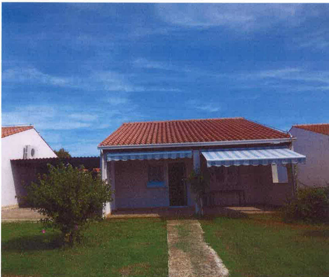
Slika 15 – Prikaz postojećeg stanja tipskog apartmana M80 (2)
