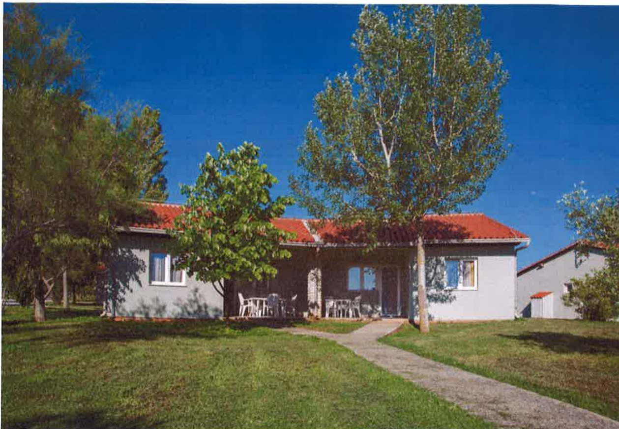
Slika 22 – Prikaz postojećeg stanja tipskog apartmana M95 (1)
