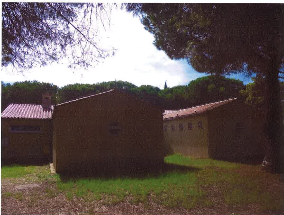
Slika 41 – Prikaz postojećeg stanja sanitarnog čvora 4 (5)
