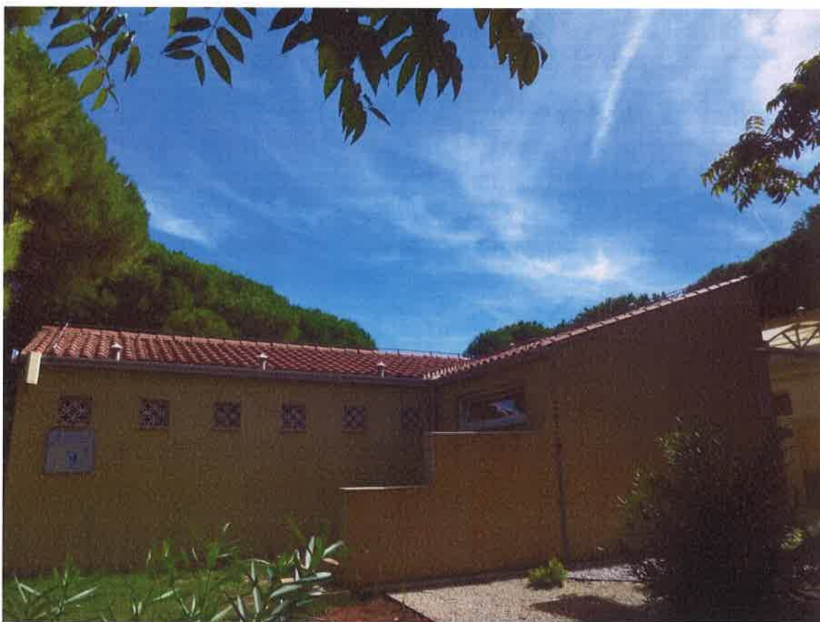
Slika 39 – Prikaz postojećeg stanja sanitarnog čvora 4 (3)
