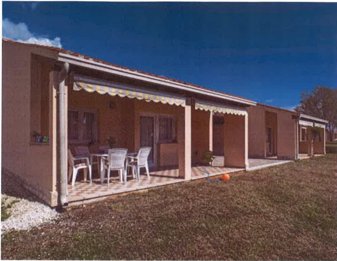
Slika 16 – Prikaz postojećeg stanja tipskog apartmana M80 (3)
