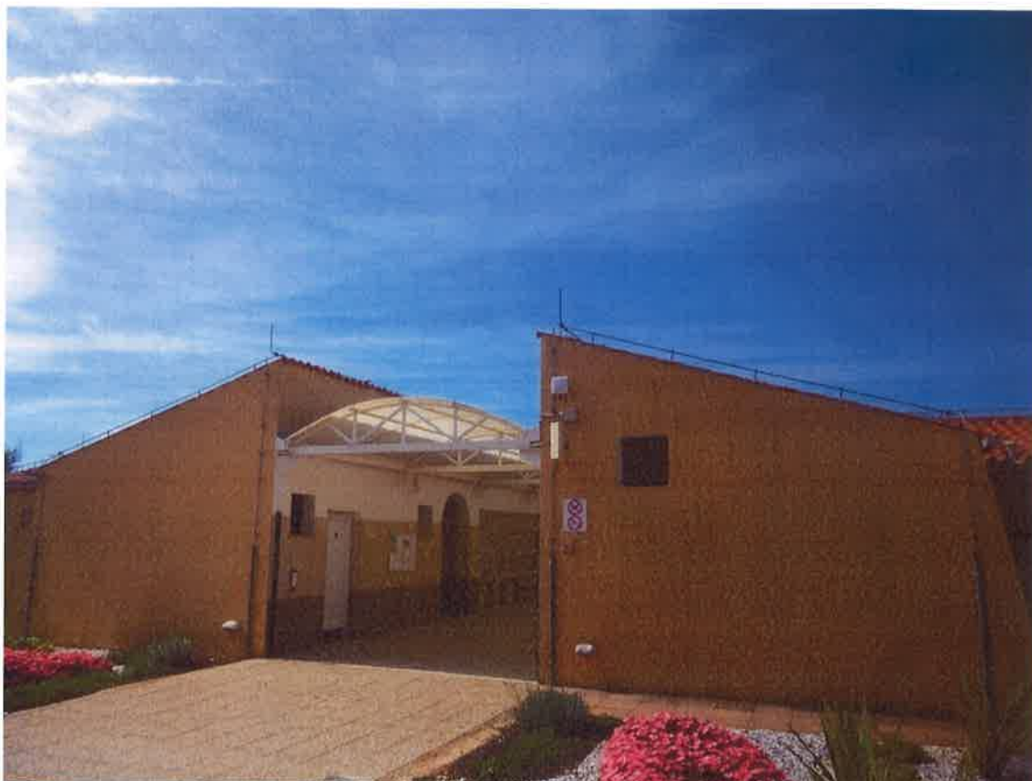
Slika 32 – Prikaz postojećeg stanja sanitarnog čvora 3 (1)
