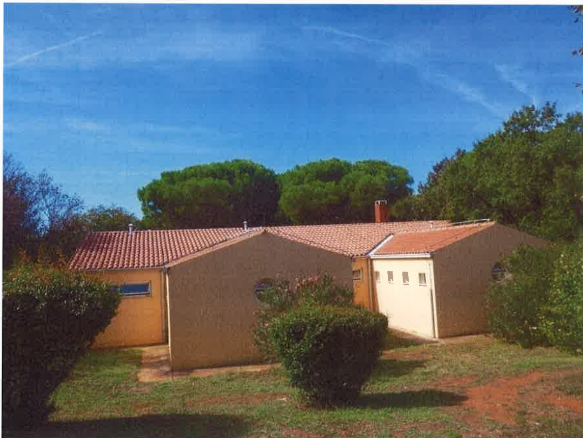
Slika 29 – Prikaz postojećeg stanja sanitarnog čvora 2 (3)
