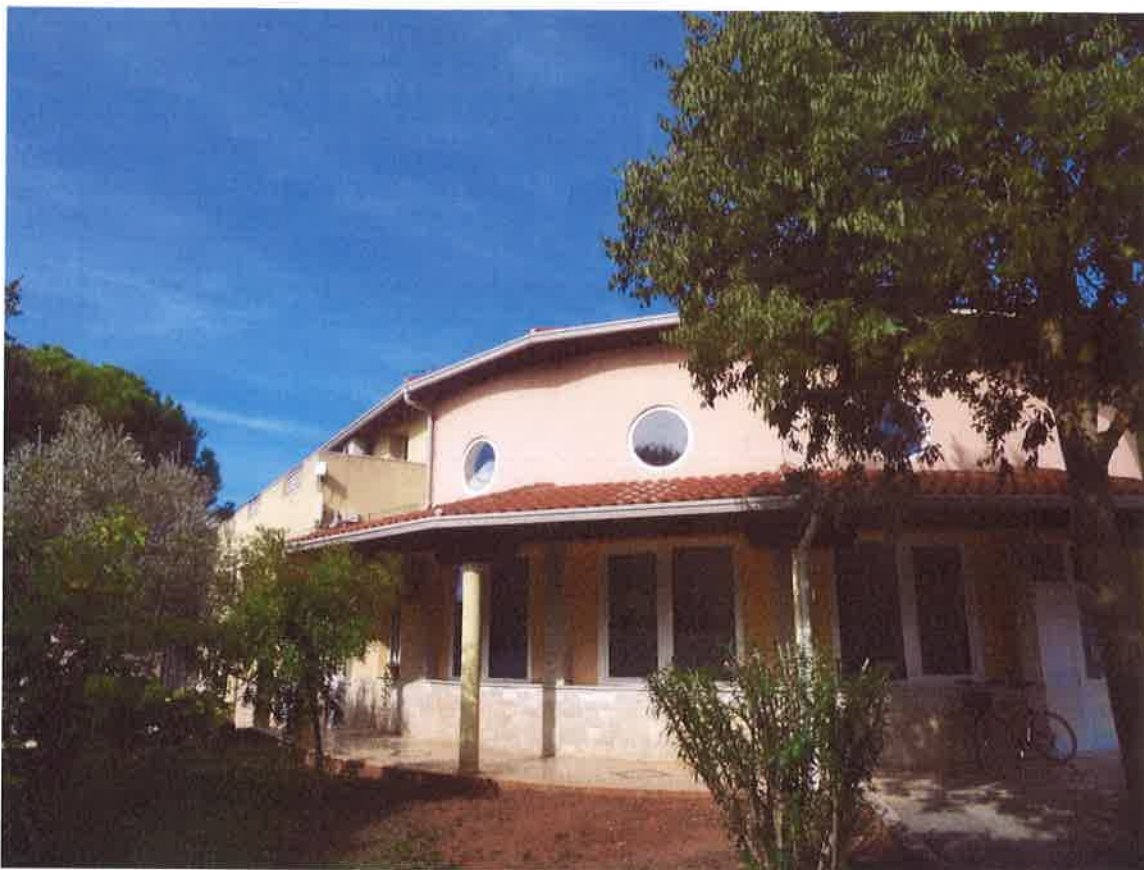
Slika 4 – prikaz postojećeg stanja upravne zgrade (1)
