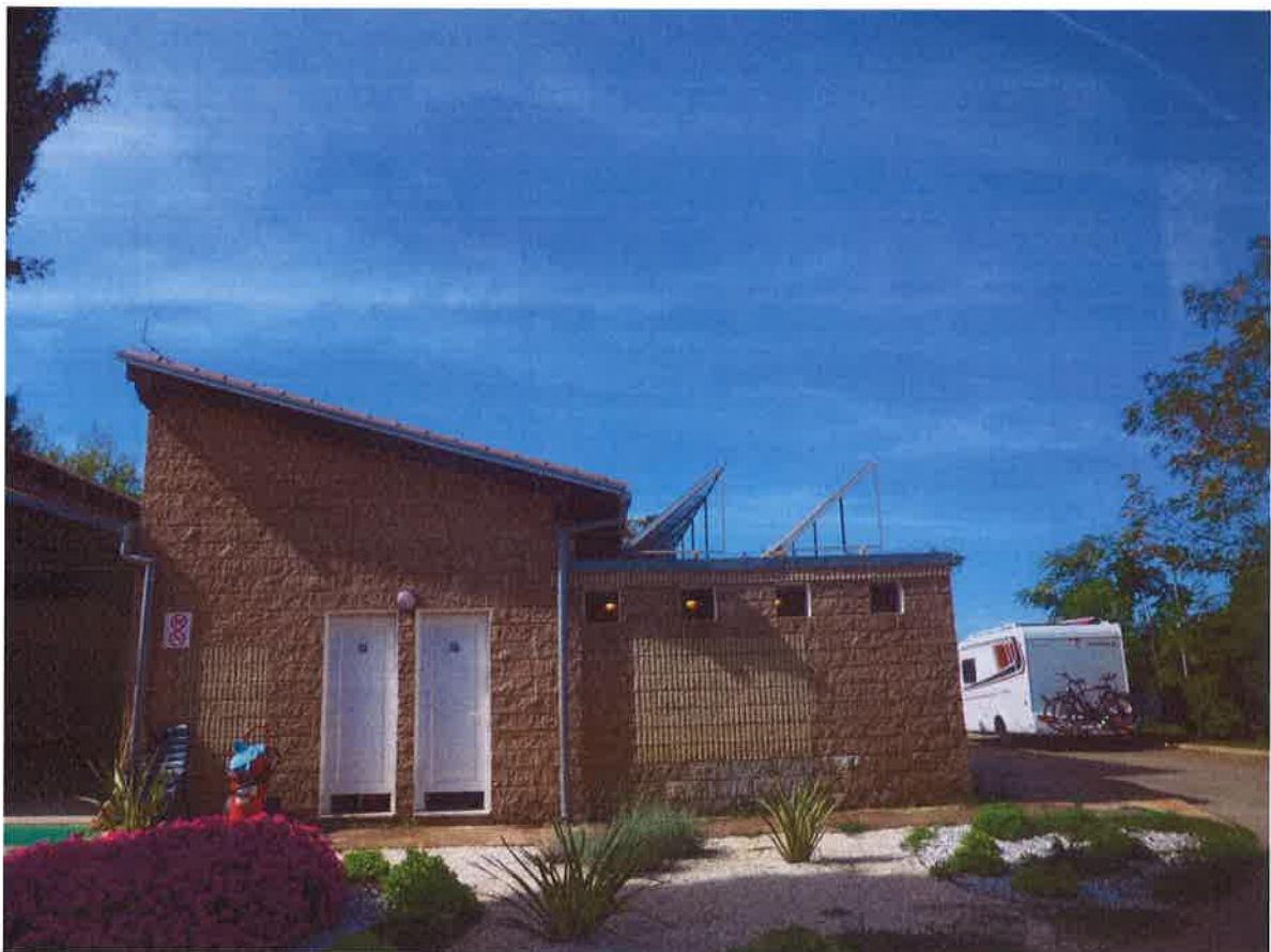
Slika 45 – Prikaz postojećeg stanja sanitarnog čvora 5 (4)
