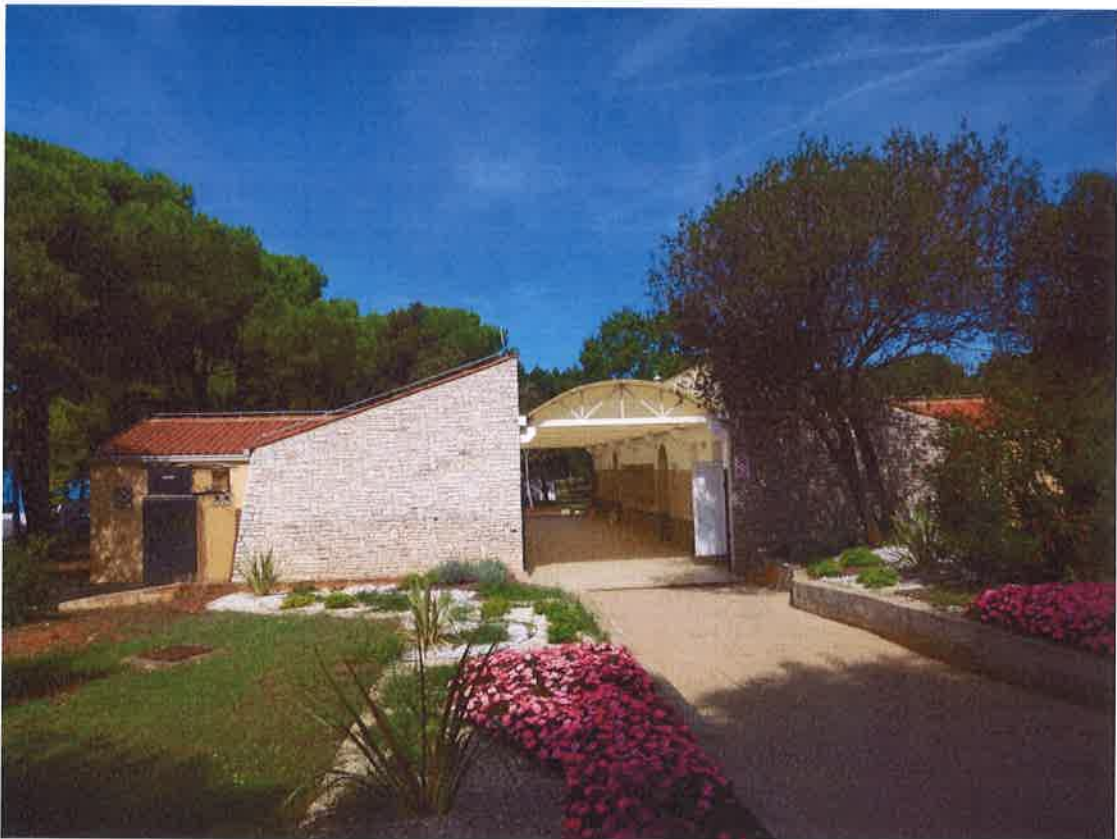
Slika 27 – Prikaz postojećeg stanja sanitarnog čvora 2 (1)
