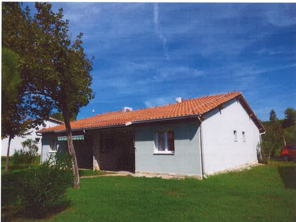
Slika 17 – Prikaz postojećeg stanja tipskog apartmana M90 (1)
