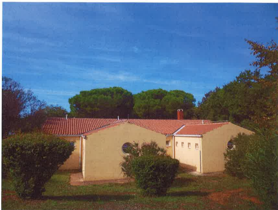
Slika 24 – Prikaz postojećeg stanja sanitarnog čvora 1 (1)
