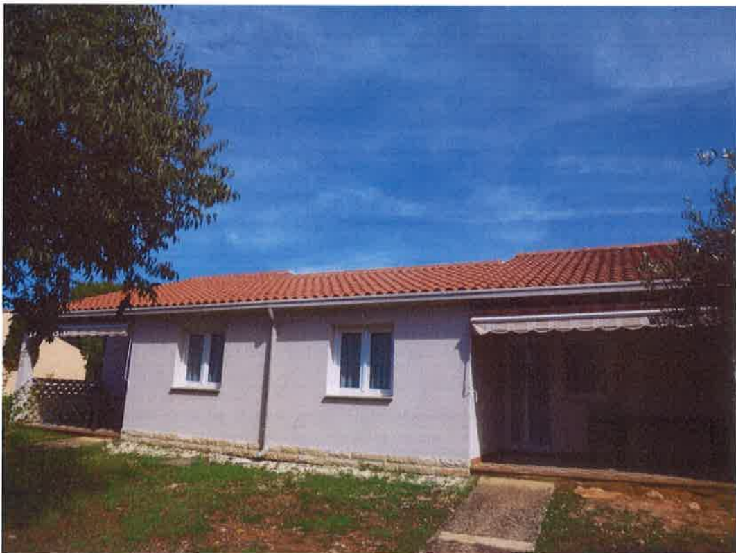
Slika 11 – Prikaz postojećeg stanja tipskog apartmana M60 (1)
