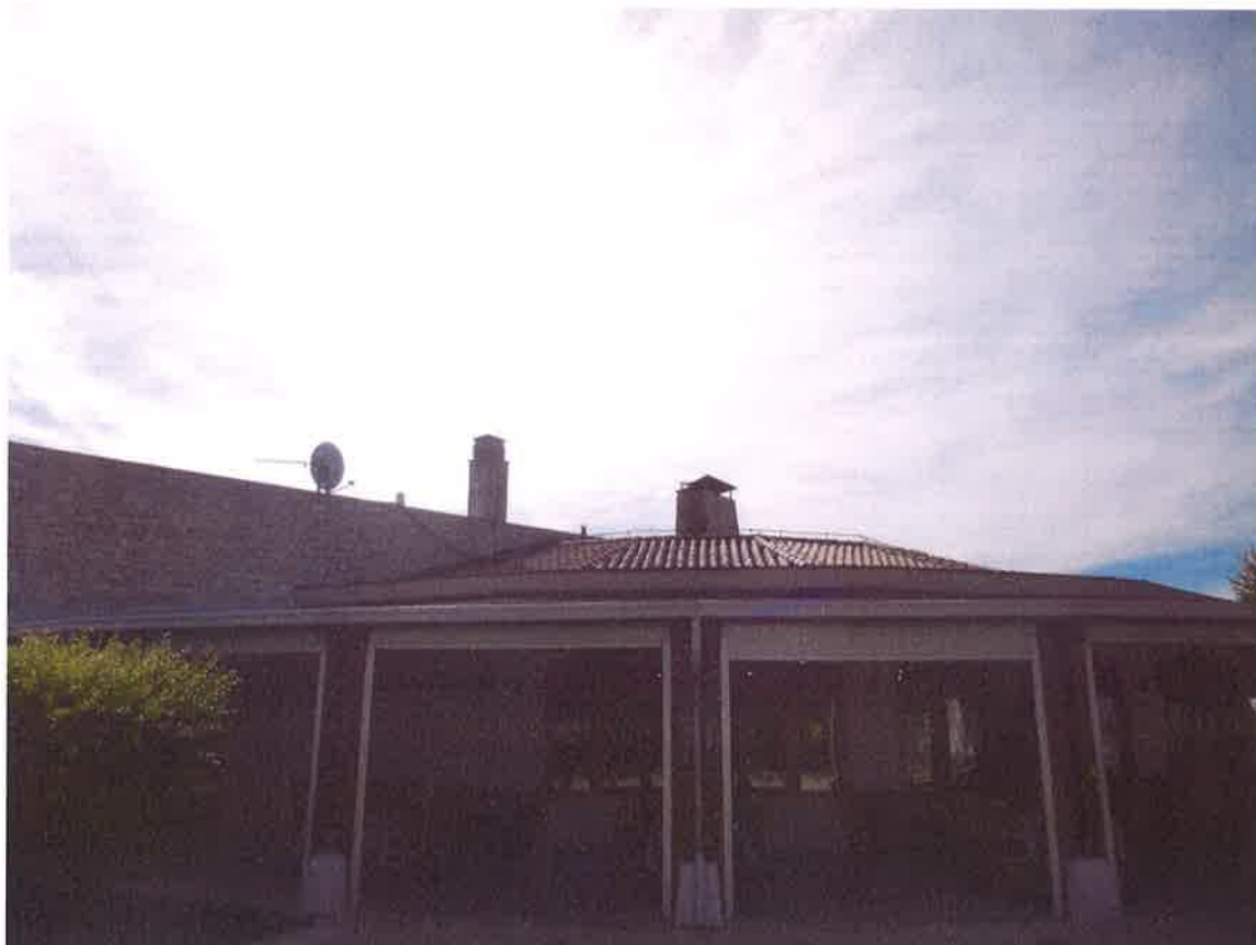
Slika 9 – Prikaz postojećeg stanja restorana (2)
