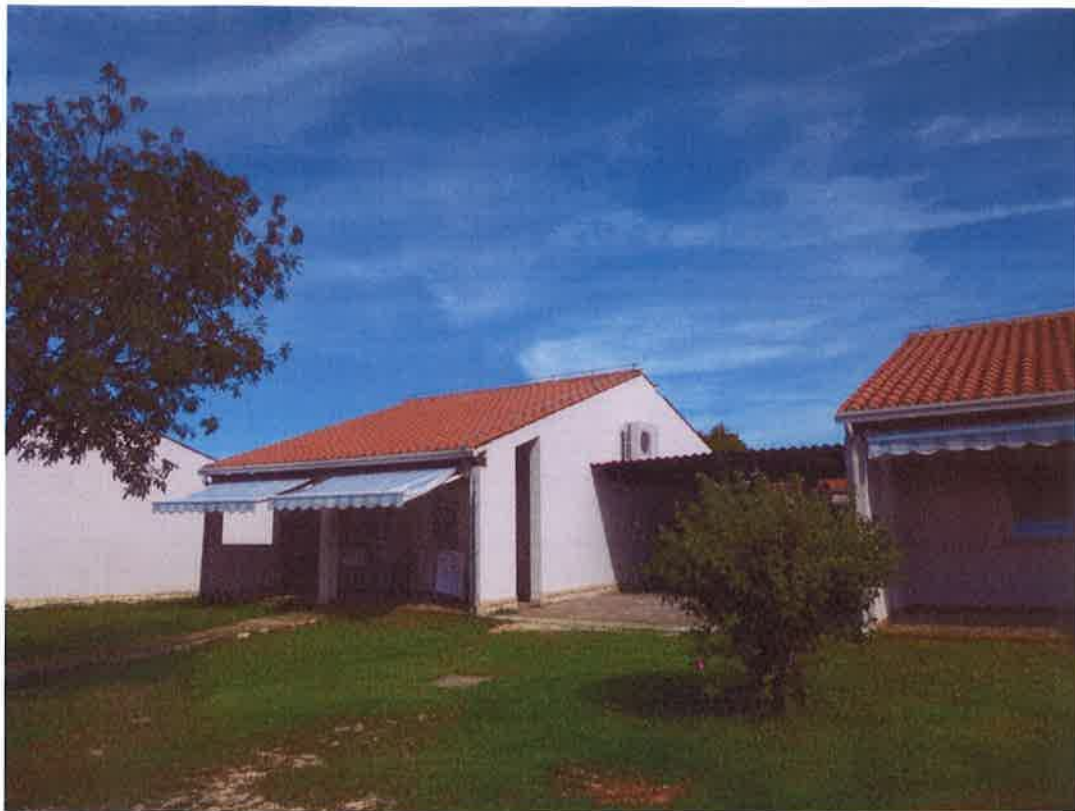
Slika 14 – Prikaz postojećeg stanja tipskog apartmana M80 (1)
